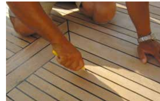
Abb. 38: Mit einem Cuttermesser wird in die zu entfernende Fuge eingeschnitten
