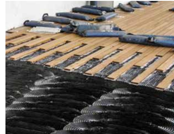
Abb. 23: In Sikaflex®-298 eingebettete und mit Gewichten fixierte Teakleisten
