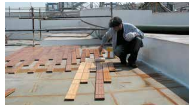
Abb. 18: Auftrag von Sika® MultiPrimer Marine mit einer Walze auf ein Teakdeck (Rückseite)
