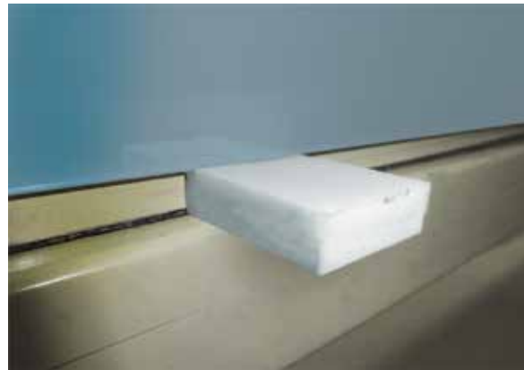
Abb. 13: Abstandsklotz im praktischen Einsatz
