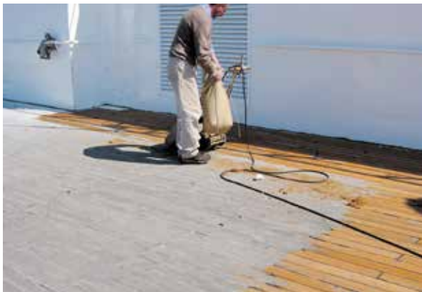
Abb. 28: Deck mit einer Industriebandschleifmaschine abschleifen
