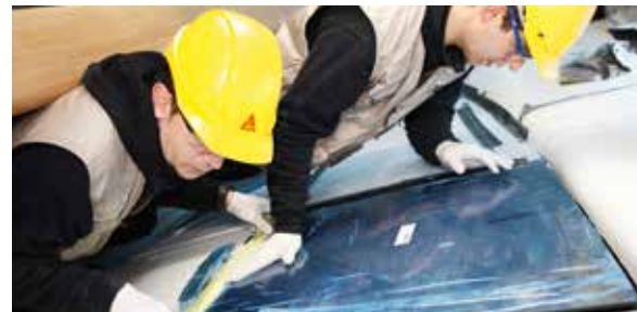
Abb. 77: Auftrag von Sikaflex®-296
