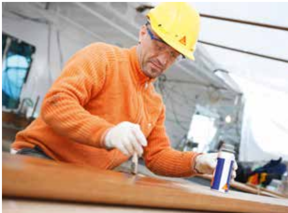
Abb. 21: Primer-Auftrag mit einem Pinsel
