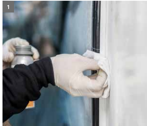
Abb. 80: Vorbehandlung des Keramiksiebdruckrands mit Sika Aktivator-100
