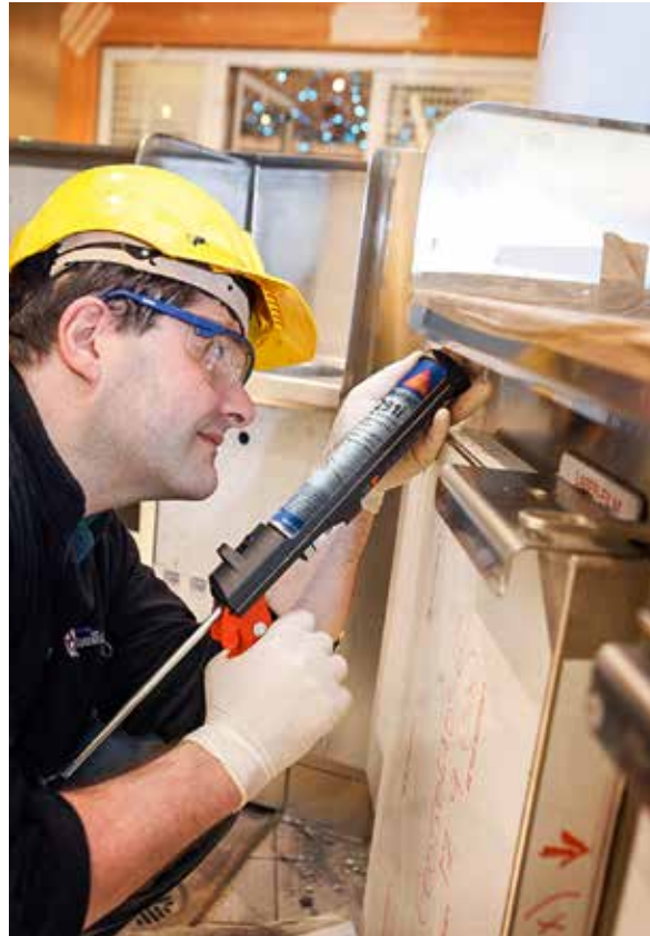
Abb. 63: Applikation von Sikaflex®-291i
