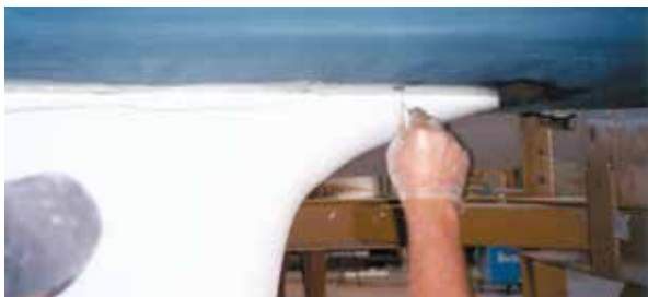
Abb. 70: Die Verbindungsfuge wird fertiggestellt
