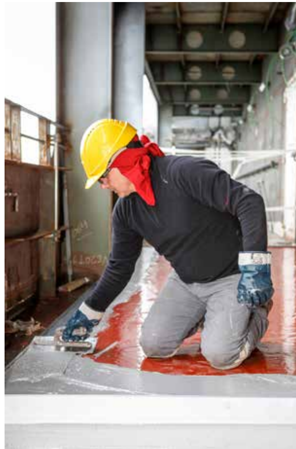
Abb. 20: Verteilen von SikaTransfloor®-352 SL mit einer Kelle
