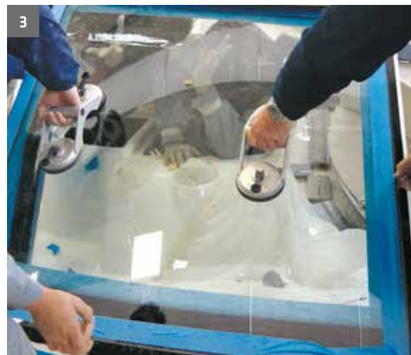
Abb. 82: Fenster einsetzen
