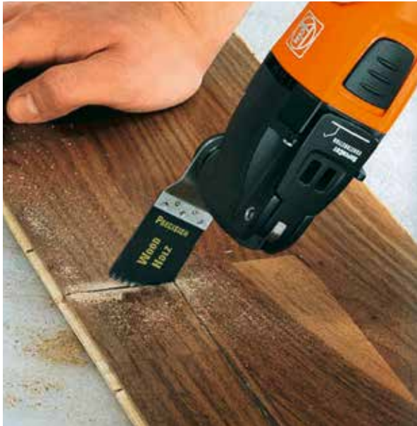
Abb. 47: Trennen der Leisten mit einer Vibrationssäge
