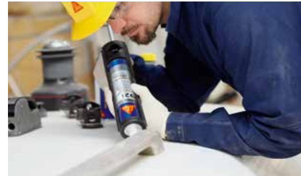
Abb. 57: Verklebung der Scheuerleiste mit Sikaflex®-292i
