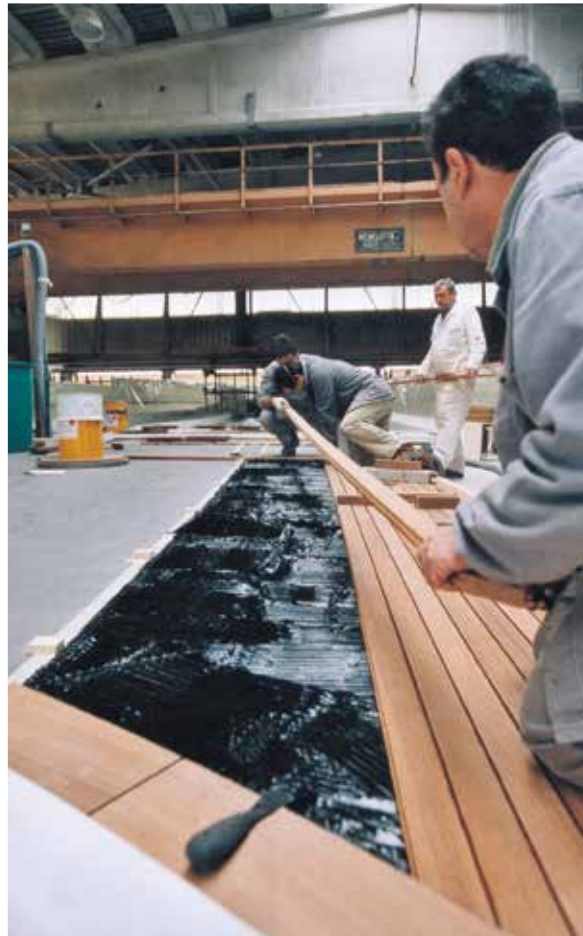
Abb. 22: Aufbringen des Decks
