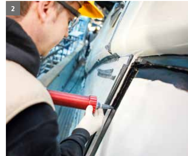
Abb. 81: Klebstoffapplikation auf die Einfassung
