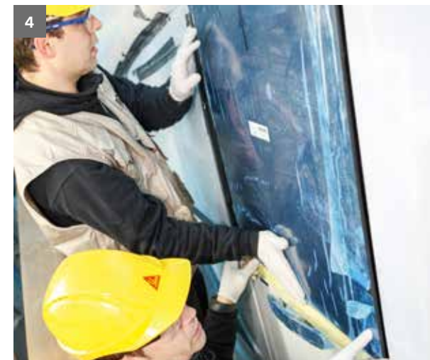
Abb. 83: Die Scheibe kann direkt nach dem Fügen noch ausgerichtet werden
