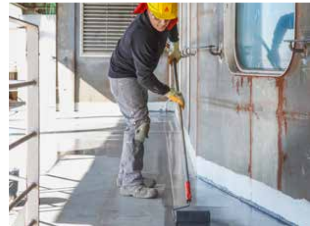
Abb. 17: Auftrag von SikaCor® ZP Primer mit einer Walze auf ein Stahldeck
