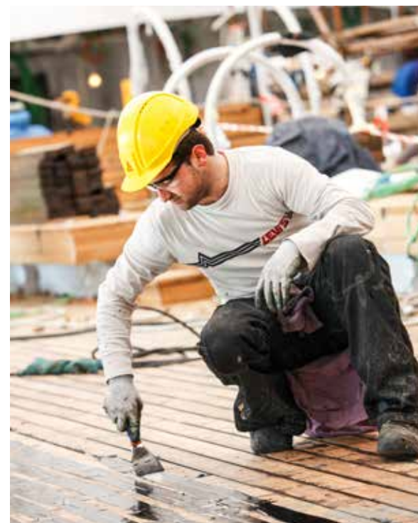
Abb. 27: Sikaflex®-290 DC PRO mit einem Spachtel abziehen und einpressen
