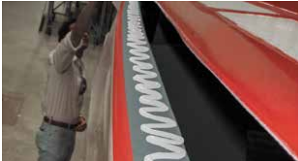
Abb. 64: Sikaflex®-292i wird dickschichtig auf die Verbindungsfläche aufgetragen: Am Bug ...
