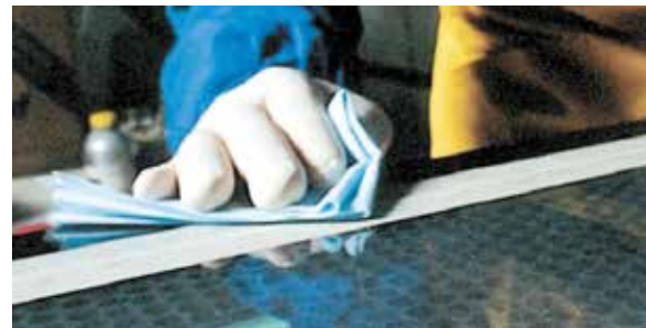
Abb. 76: Auftrag von Sika® Aktivator
