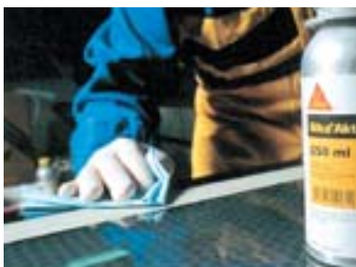
Abb. 38 Auftrag von Sika® Aktivator
