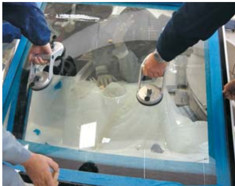
Abb. 45 Fenster einsetzen
