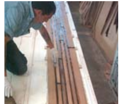
Abb. 15 Sikaflex®-290 DC mit einem Spachtel abziehen und einpressen
