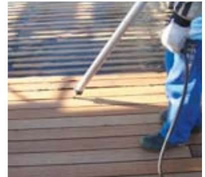
Abb. 14 Mit Sikaflex®-290 DC verfugen
