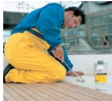
Abb. 8 Auftrag von Sika® Primer-215 mit einer Walze auf eine GFK-Oberfläche
