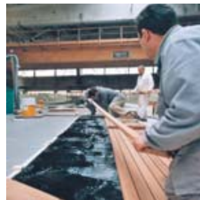
Abb. 9 Aufbringen des Decks
