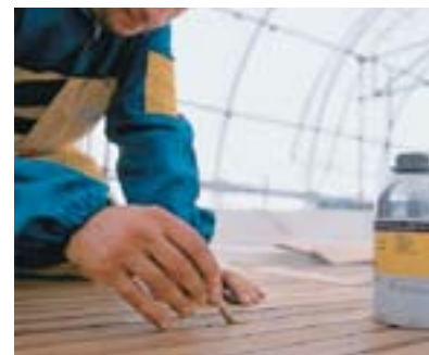
Abb. 11 Sorgfältiges Aufbringen von Sika® Primer-290 DC
