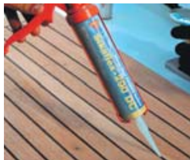
Abb. 10 Verfugen mit Sikaflex®
