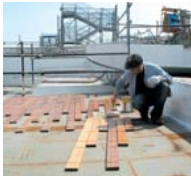
Abb. 7 Auftrag von Sika® Primer-290 DC mit einer Walze auf ein Teakdeck (Rückseite)
