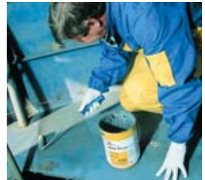
Abb. 6 Auftrag von SikaCor® ZP Primer mit einer Walze auf ein Stahldeck
