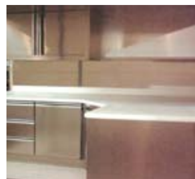
Abb. 51 Eine mit Sikaflex® eingebaute Arbeitsfläche in der Schiffsküche
