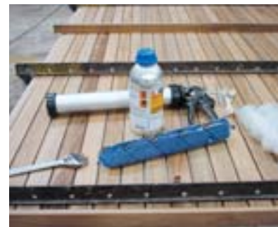
Abb. 16 Stabdeck zur Aushärtung eingespannt
