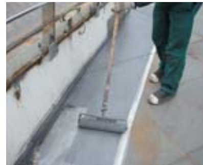
Abb. 18 Auftrag von SikaCor® ZP Primer mit einer Walze
